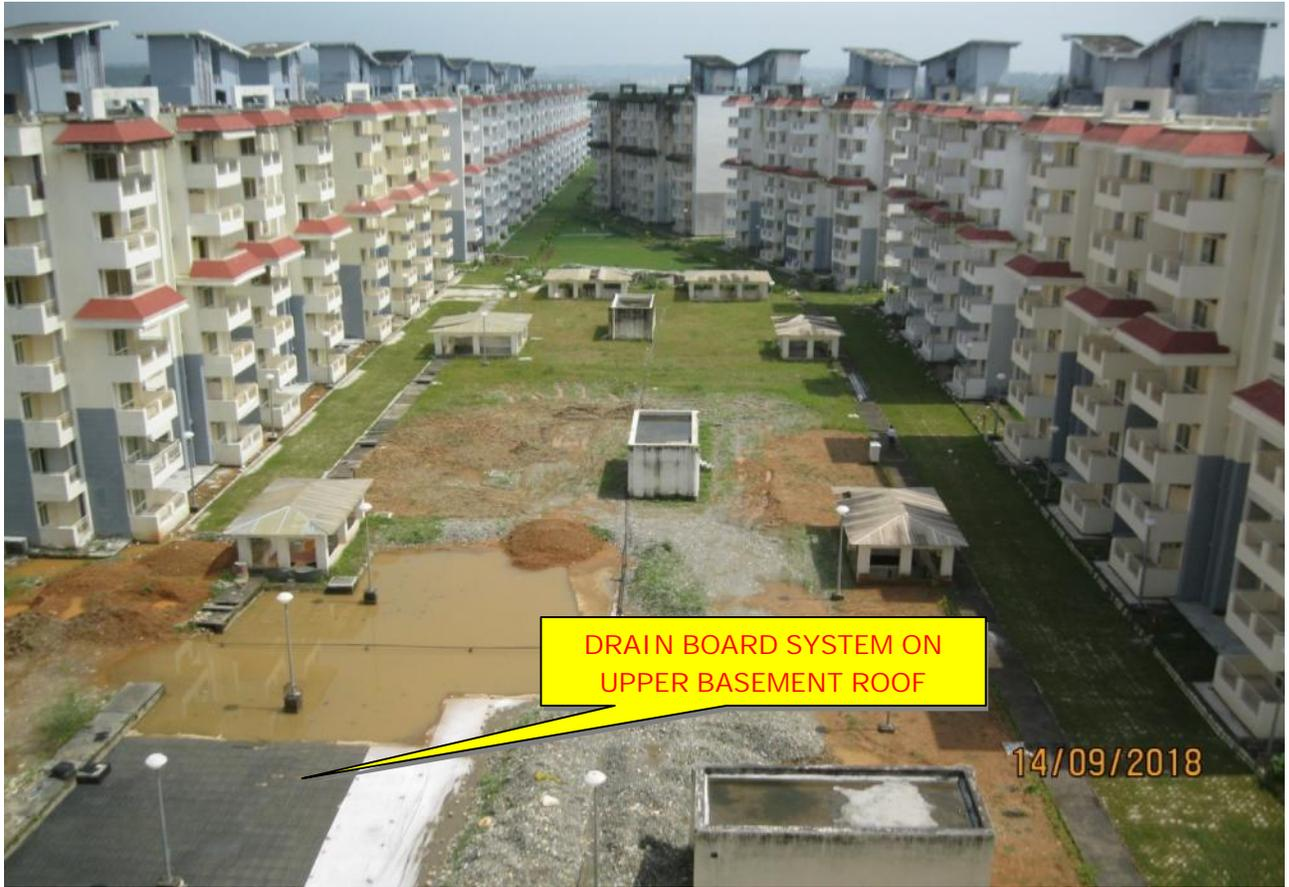
**DRAIN BOARD SYSTEM ON
